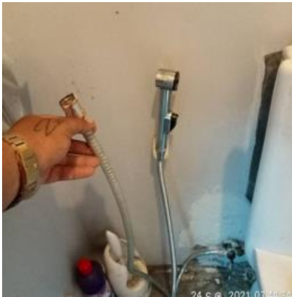
ภาพถ่ายที่ 2.2-26การแก้ไขสายฉีดชำระที่น้ำรั่วซึม
