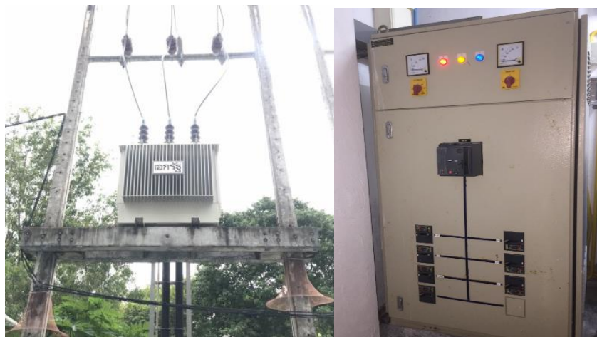
รูปที่ 1-9 หม้อแปลงไฟฟ้าและ Circuit Breaker
