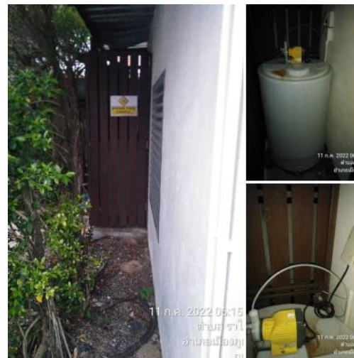
ภาพถ่าย การตรวจสอบระบบเติมคลอรีนระบบบำบัดน้ำเสีย
